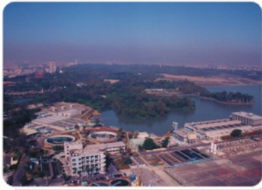
中宇環保工程公司完成高雄澄清湖淨水場增設高級淨水處理設備工程鳥瞰圖
