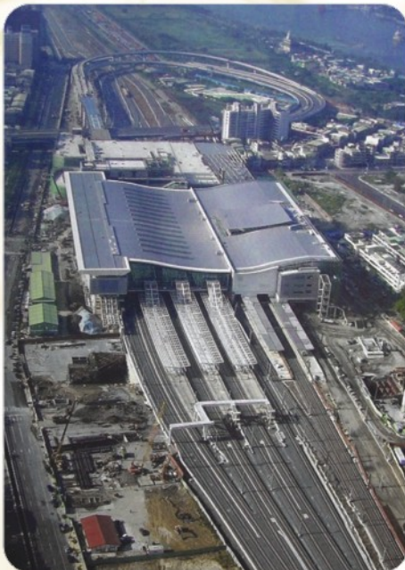
中鋼結構公司承作高鐵左營車站鋼結構工程
