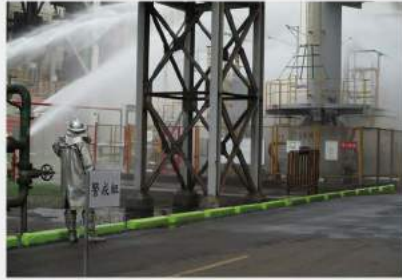
槽區偵測系統偵測氮氣洩漏，立即噴灑水霧防止氮氣大量擴散
