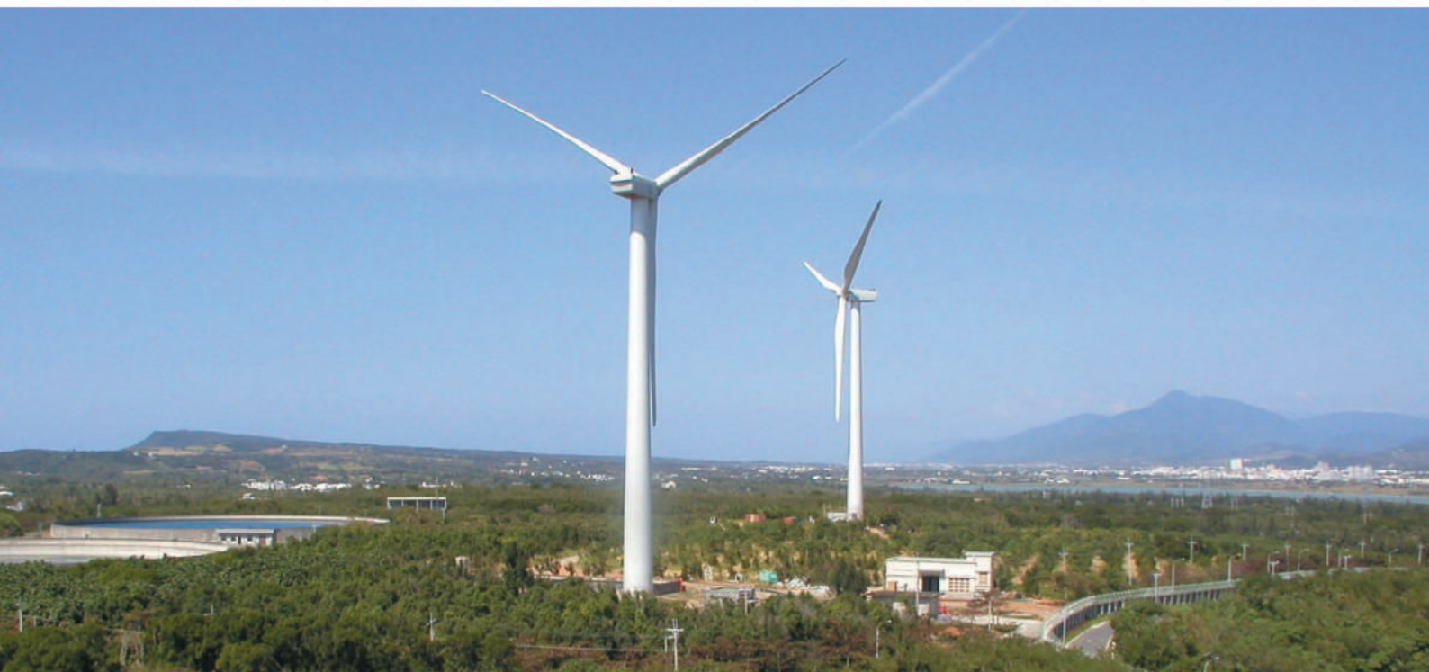
中鋼機械公司承製的核三風力發電機塔架
