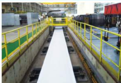
中鋼住金越南公司酸洗塗油線
