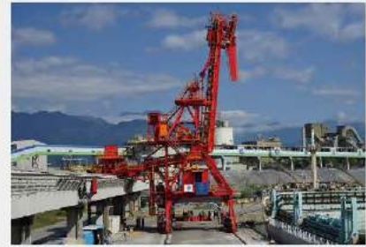
新裝船機設備
