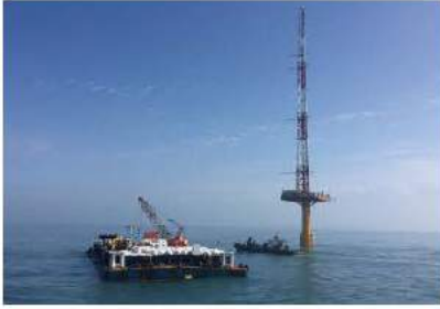
台電南區海氣象觀測塔新建工程施工作業
