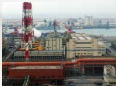
中龍第二期第二階段擴建工程 - 動力工場
