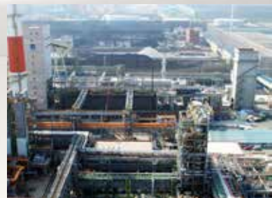
中龍第二期第二階段擴建工程 - 煉焦工場
