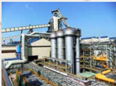
中龍第二期第二階段擴建工程 - 高爐工場
