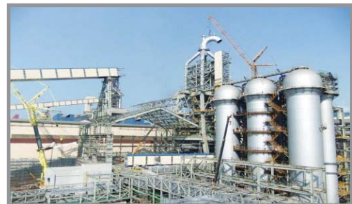
中龍二號高爐安裝工程
