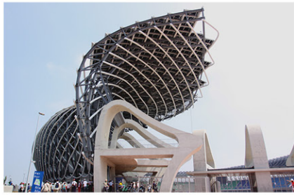
使用銲接及高張力構造用鋼 SM490A、A572 Gr.50 所建造的高雄世運主場館。
