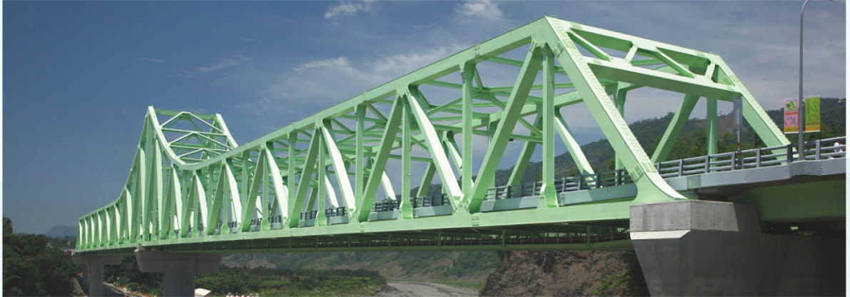
使用耐候橋梁用鋼 A709 Gr.50W：中鋼公司捐贈之新發大橋
