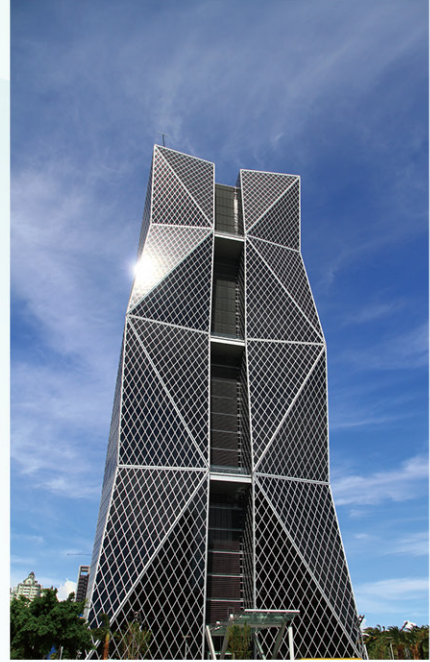
使用建築結構用鋼 SN490B、SN490C 所建造的中鋼總部大樓。
