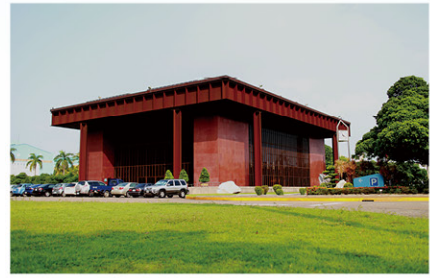
使用耐候結構用鋼 A588 之中鋼公司大禮堂
