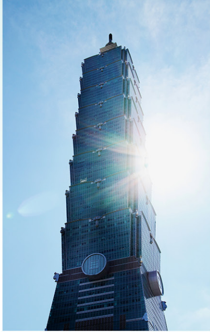
使用超高強度耐震結構用鋼 SM570M 之台北 101 大樓
