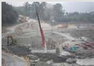
沉箱施工情形
