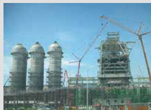
（五）中龍一號高爐
