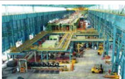
中鋼新線材工場全區
