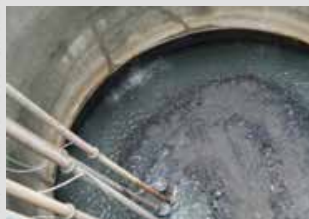
沉箱內抽水情形
