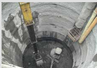
井基內開挖施工
