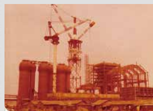
（四）中鋼一號高爐
