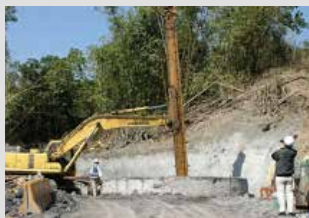
山坡側井基施工
