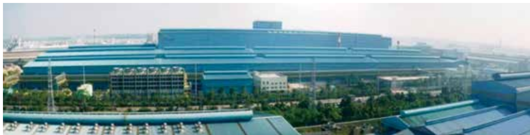
中鋼第三冷軋產線全景
