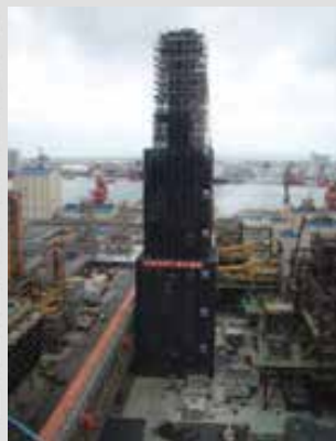
二階工程興建中的鍋爐煙囪
