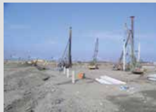
96 年動力工場工地打樁情況
