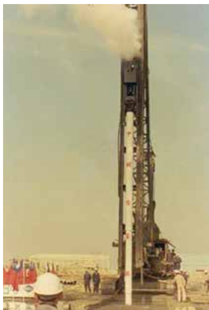
63 年 9 月 1 日 在鋼板工場打下第一支雷蒙基樁
