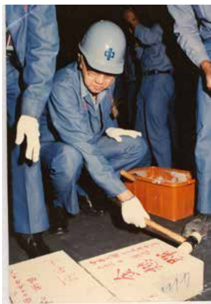
75年11月26日 三號高爐爐本體築爐工程開工典禮，董事長金 懋暉親自主持
