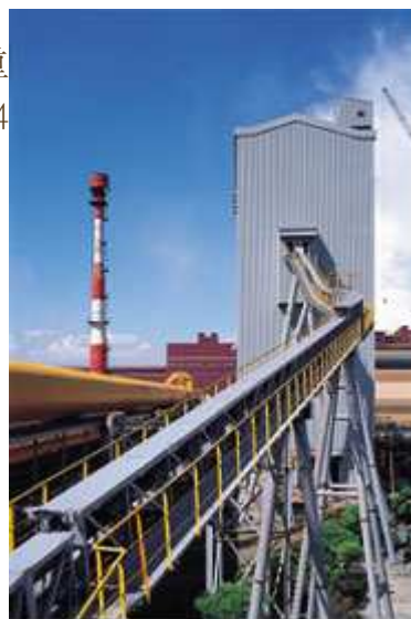
高爐噴煤設備
