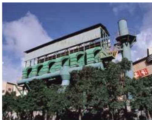
石料處理集塵設備
