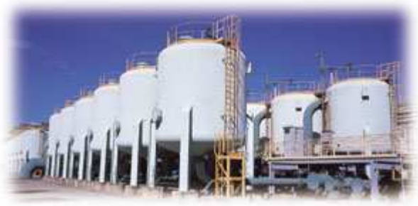
鋼品用途之一：儲槽
