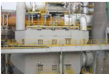
壹號高爐廢熱回收設備
