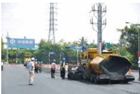
以轉爐石瀝青混凝土鋪築道路
