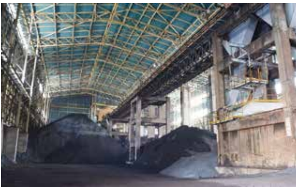
燒結礦自動化封閉式建築
