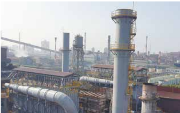
第一轉爐工場二號集塵機汰舊
