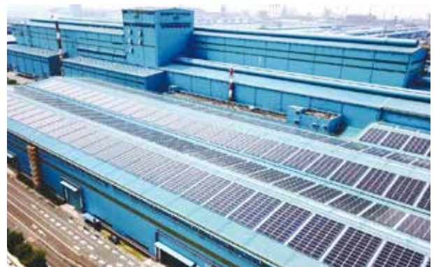
第三冷軋廠區太陽光電建置工程
