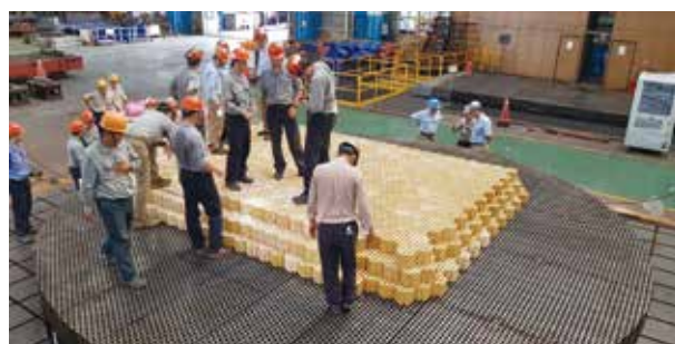
熱風爐蓄熱磚支撐座自主開發
