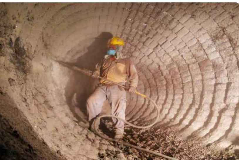
打除魚雷車殘渣作業
