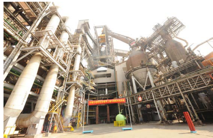
四號高爐第二爐打開爐
