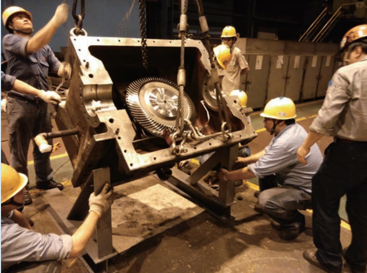
設備搶修作業
