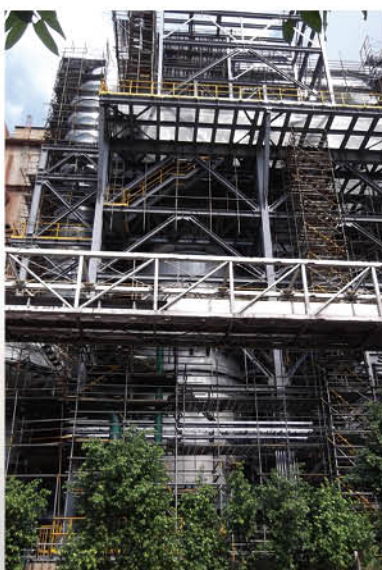
四號燒結增設排氣脫硫設備
