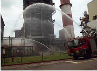
水霧自動灑水系統、消防水槍、消防車噴灑水霧，壓制液氨外洩
