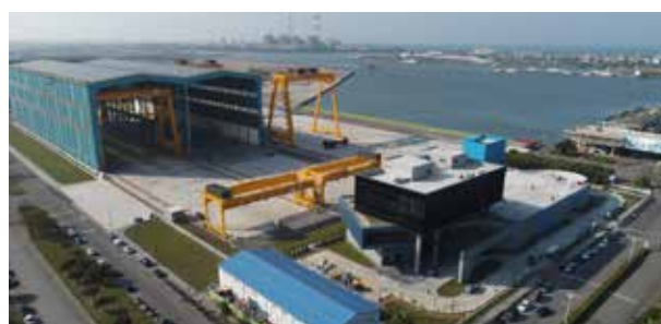
臺灣首座海洋基礎設備專業廠 - 興達海基
