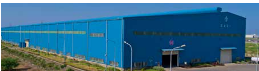
中鋼印度公司廠房全景
