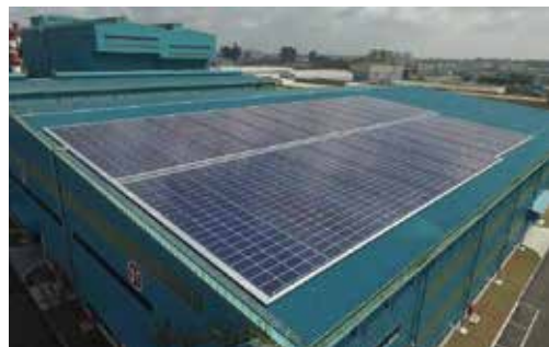
中鋼茂大冷軋鋼品倉庫屋頂光電設置
