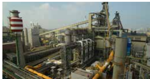
中龍二期二階高爐本體製作及設備安裝
