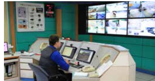
駐衛安全管制中心
