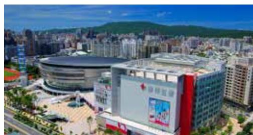
高雄巨蛋綜合體育館暨商場
