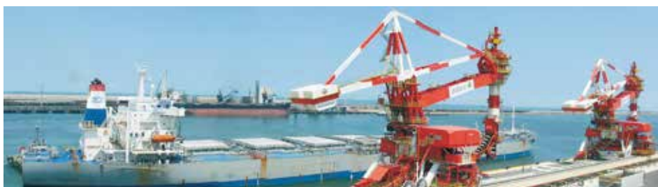
中龍連續卸船機製造安裝
