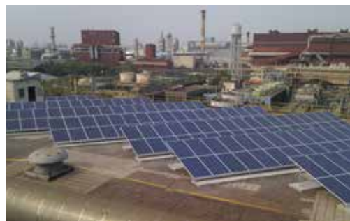
中鋼動力工廠屋頂光電設置
