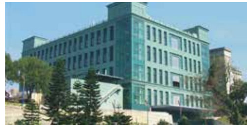
生技建廠工程
