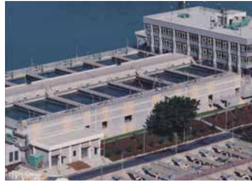
高級淨水處理設備工程
