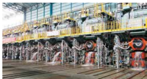
中龍熱軋設備製造及安裝
