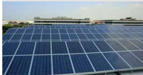
中鋼中正堂水泥屋頂光電設置
