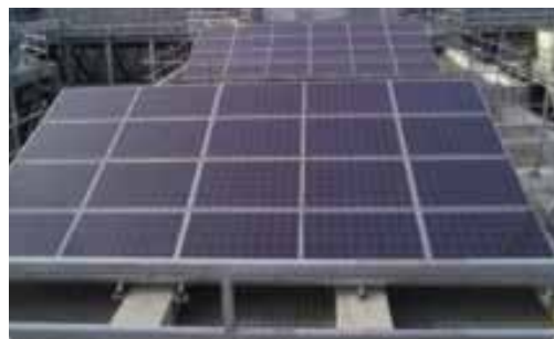
中鋼總部大樓屋頂光電設置
