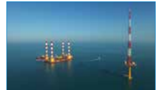
氣象觀測塔完工照片
