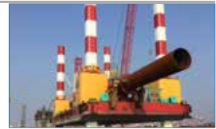
氣象觀測塔施工情形
