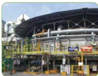
2008年啟用的轉底爐製程，除了可提升集塵灰及礦泥在廠內的回收量，降低燒結場戴奧辛的排放外，也可產出附加價值較高的直接還原鐵及粗氧化鋅(鋅含量>50%，可外售日本提煉鋅金屬)，提昇礦泥及集塵灰的回收價值。
