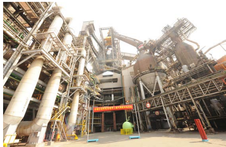
四號高爐第二爐代開爐
