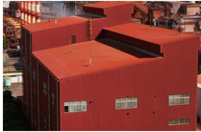
彩色鋼片 ( 廠房外牆及屋頂浪板 )
