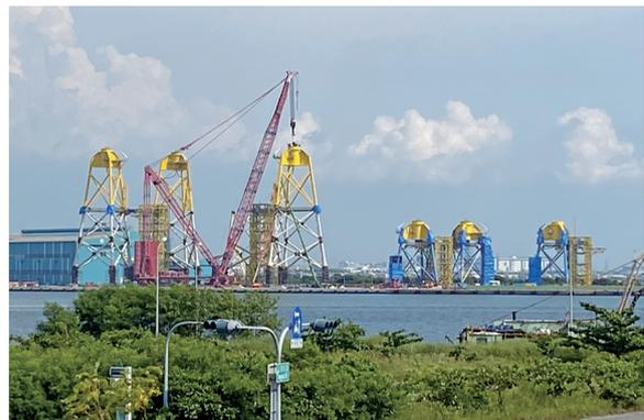
■ 六座管架式水下基礎，左二為 110 年 7 月初已完成產製之第一座百分之百國產化水下基礎，左一、左三已進入大組二工站、右一~三已進入大組一工站。
