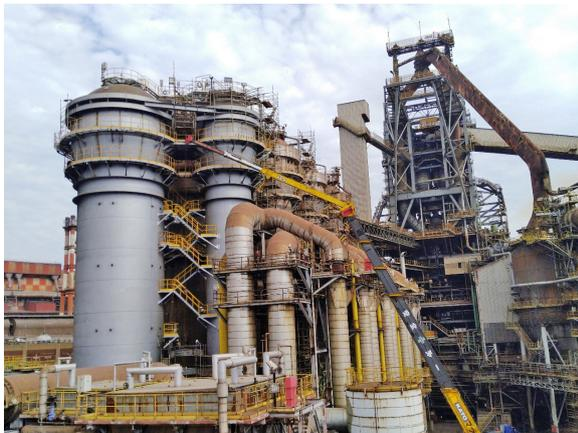
■ #34 熱風爐完工照片，為集團公司 EPC 自主化工程奠定良好基礎。
