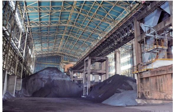
■ 燒結礦自動化封閉式建築完工後內部儲存情形。
