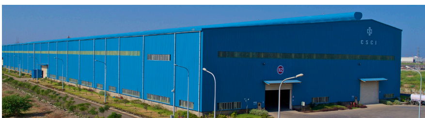
中鋼印度公司廠房全景
