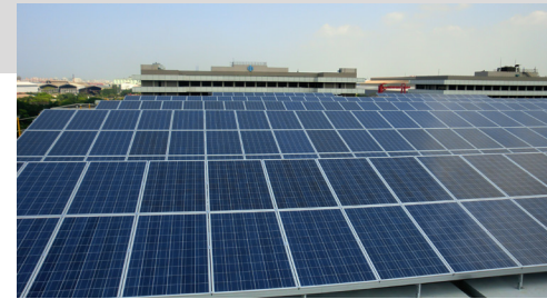
中鋼中正堂水泥屋頂光電設置
