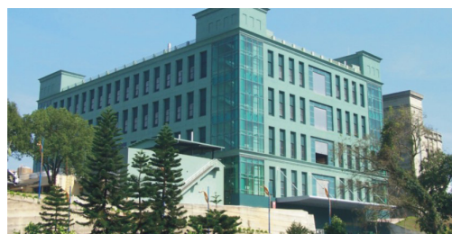
生技建廠工程
