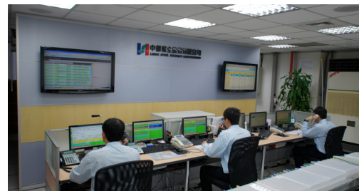
系統保全 24 小時管制中心
