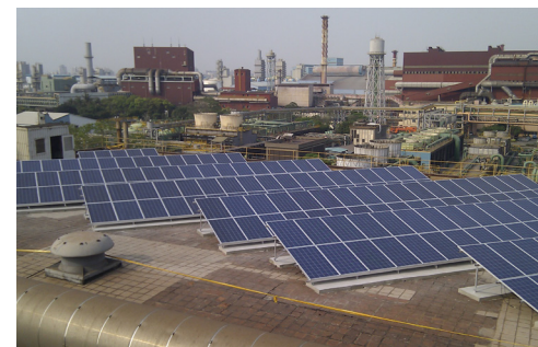
中鋼動力工廠屋頂光電設置
