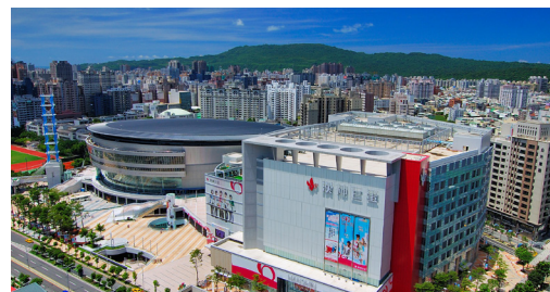
高雄巨蛋綜合體育館暨商場
