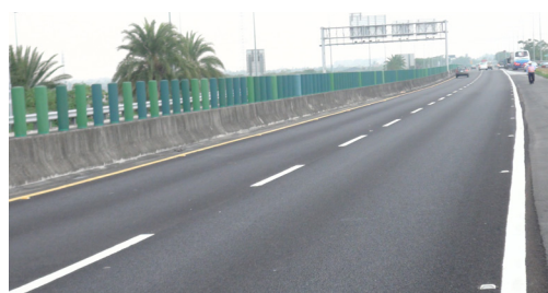
轉爐石瀝青混凝土應用實績 (國道 3 號南州段)
