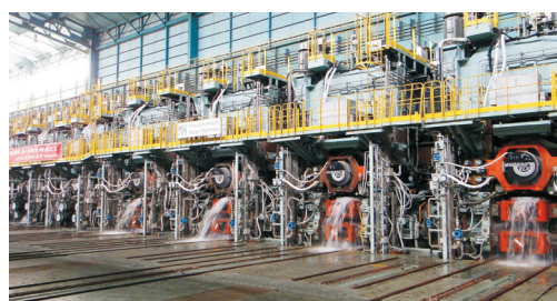
中龍熱軋設備製造及安裝
