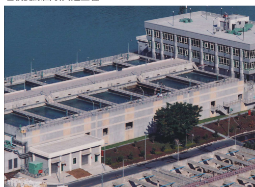
高級淨水處理設備工程
