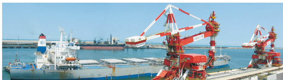
中龍連續卸船機製造安裝
