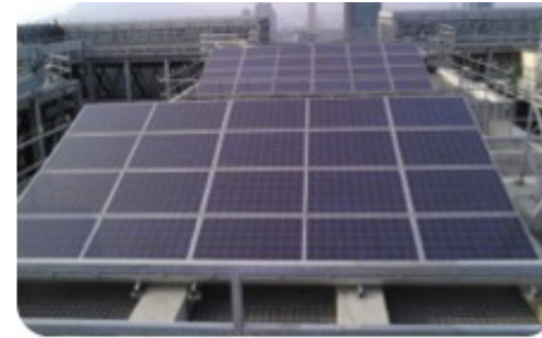
中鋼總部大樓屋頂光電設置
