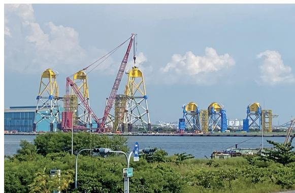
■ 六座管架式水下基礎，左二為 110 年 7 月初已完成產製之第一座百分之百國產化水下基礎，左一、左三已進入大組二工站、右一～三已進入大組一工站。
